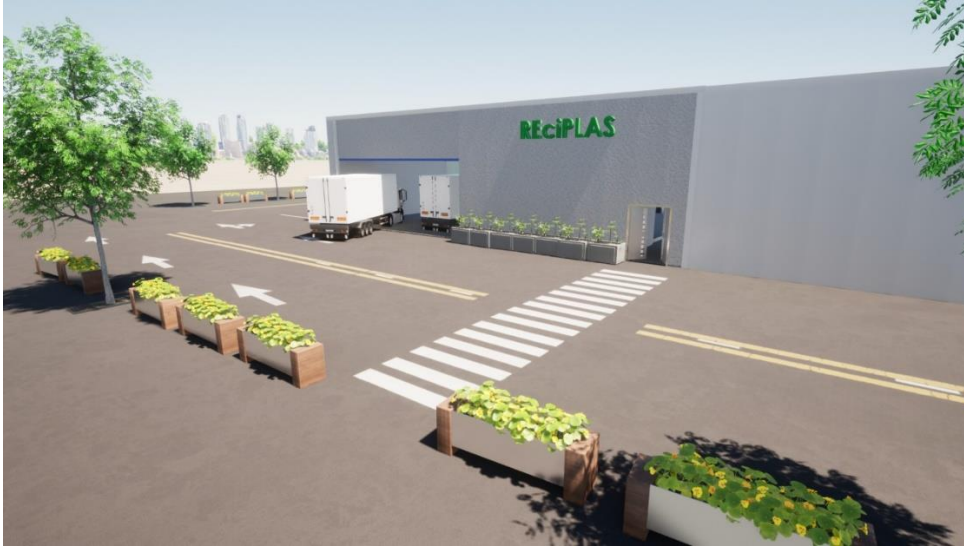
Imagen 43. Fachada lateral izquierda de la planta Fuente: Autoría propia
