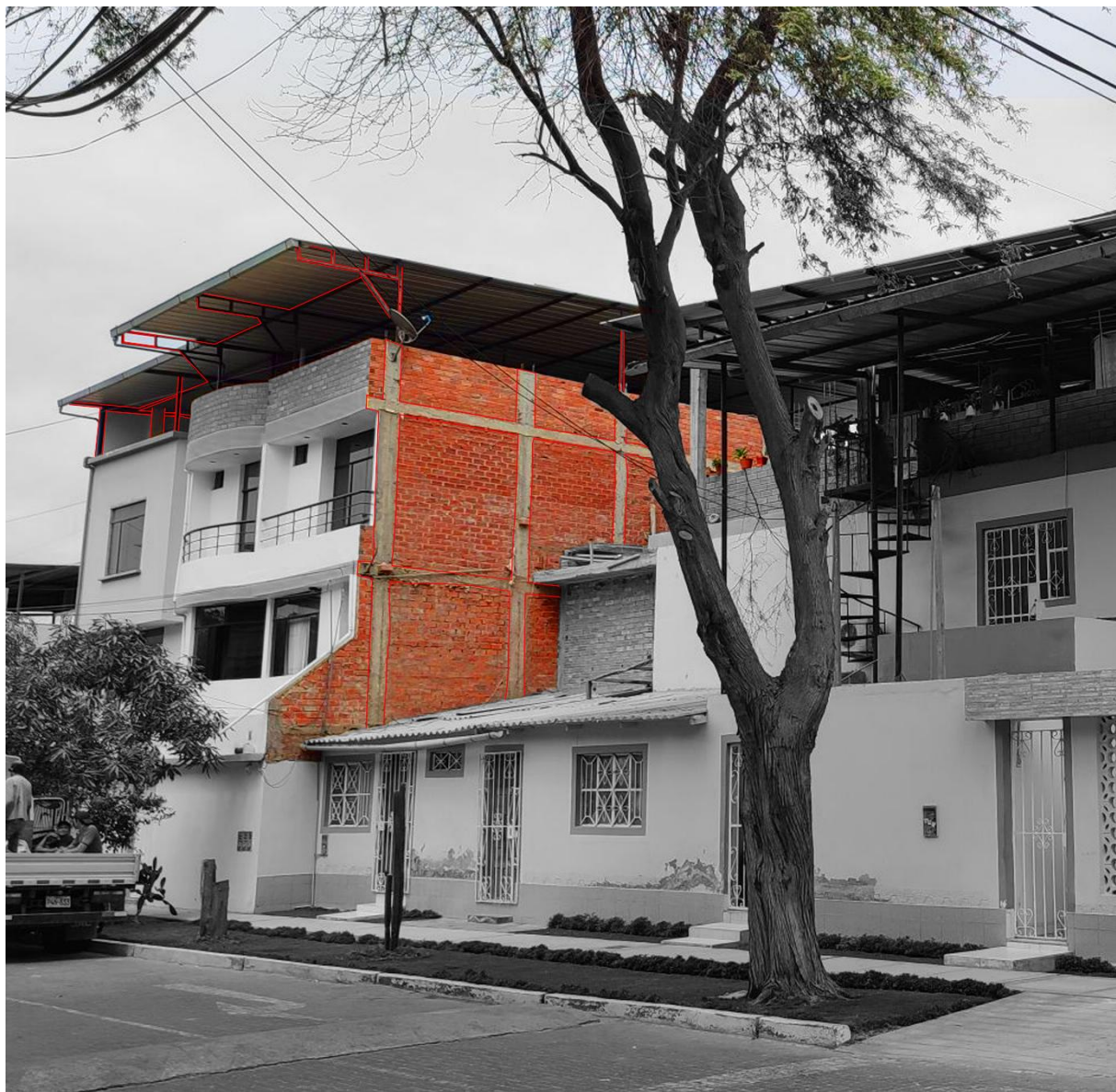
Estructura de la vivienda existente
