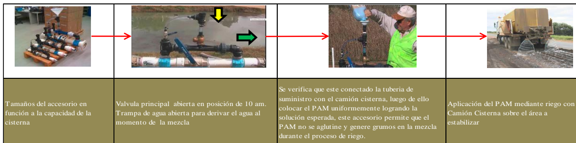
Figura 2: Proceso de aplicación del PAM mediante la vía húmeda en Australia
