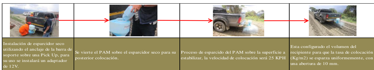
Figura 3: Proceso de aplicación del PAM mediante la vía seca en Australia
