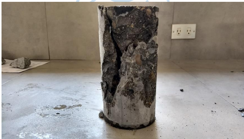
Figura 22. Cono formado sobre una base y desplazamiento de grieta vertical a través de las capas.
