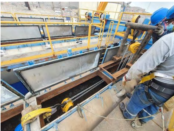
Figura 85. Tecele anclado en la carcasa para jalar el rotor.
