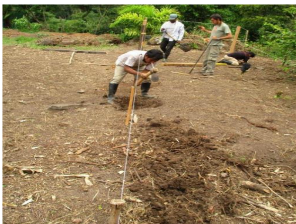
Figura 23. Delimitación del piso del secador
