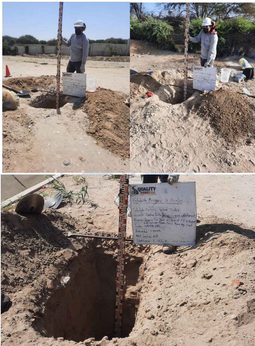
Figura 17 Culminación de calicatas
