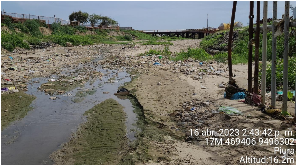
Quebrada Santa Rita – Vista hacia aguas abajo
