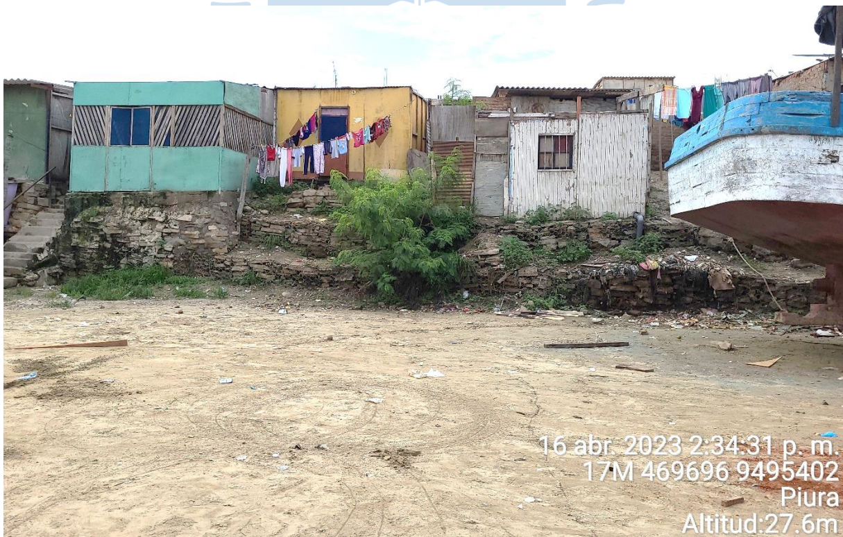
Quebrada Santa Rita – Zona de gaviones
