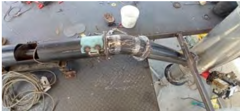
Figura 26 Instalación del sistema de alimentación.
