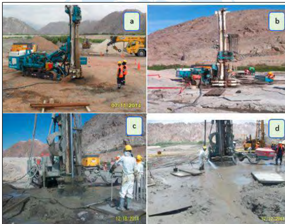
Figura 63: Proceso constructivo de jet grouting en puente Quilca Fuente: a) Pre perforación, b) Perforación, c) Inyección de lechada y d) Resurgencia. Tomado de (Consortio Vial Quilca - Matarani, 2018)
