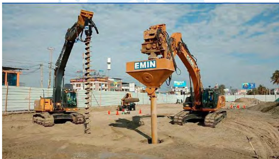
Figura 64: Aplicación de método de vibro sustitución en el bypass Fuente. Tomado de (EMIN GEOESTRUCTURAS, 2018)
