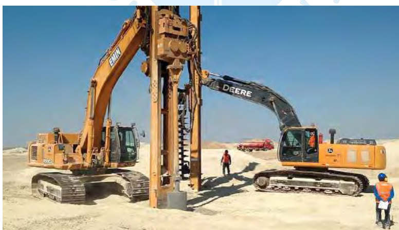
Figura 66: Aplicación de método de vibro sustitución en la planta industrial, Paita - Piura
