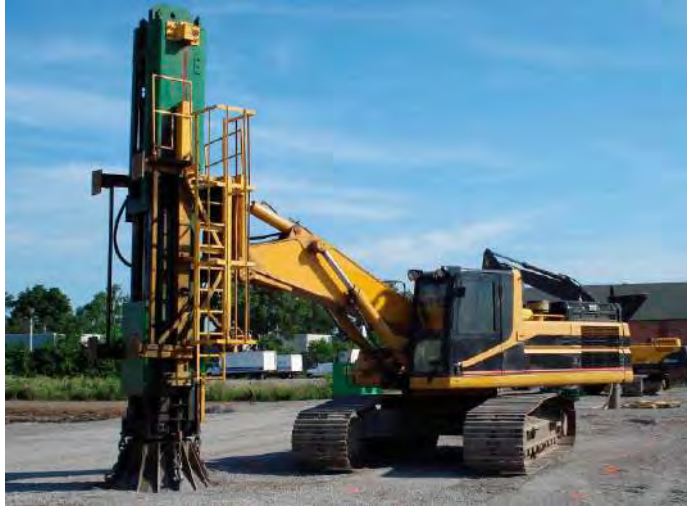
Figura 24: Compactación dinámica rápida (CDR)
