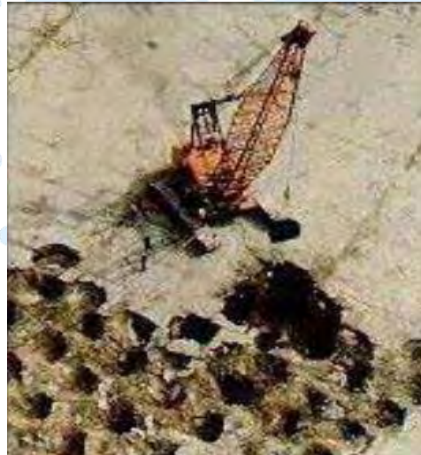
Figura 21: Impactos de energía de compactación dinámica clásica Fuente. Tomado de (Henríquez, 2007).
