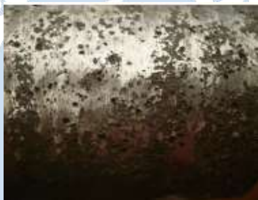
Figura 18. Picaduras superficiales en la superficie de la pieza M1, Taller 10
