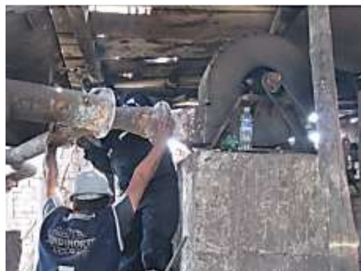
Figura 10. Ventilador centrífugo de horno de cubilote de Taller 6
