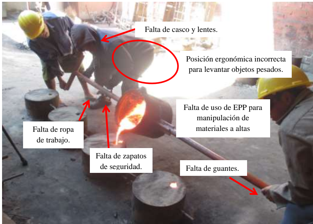
Figura 27. No utilizan EPP básicos (guantes, cascos, zapatos de seguridad y ropa de trabajo) ni especiales para altas temperaturas (Taller 1). Además, las posiciones ergonómicas son inadecuadas.
