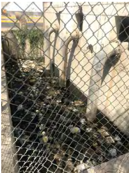
Figura 19 Cisterna de la estación de bombeo de Ignacio Merino
