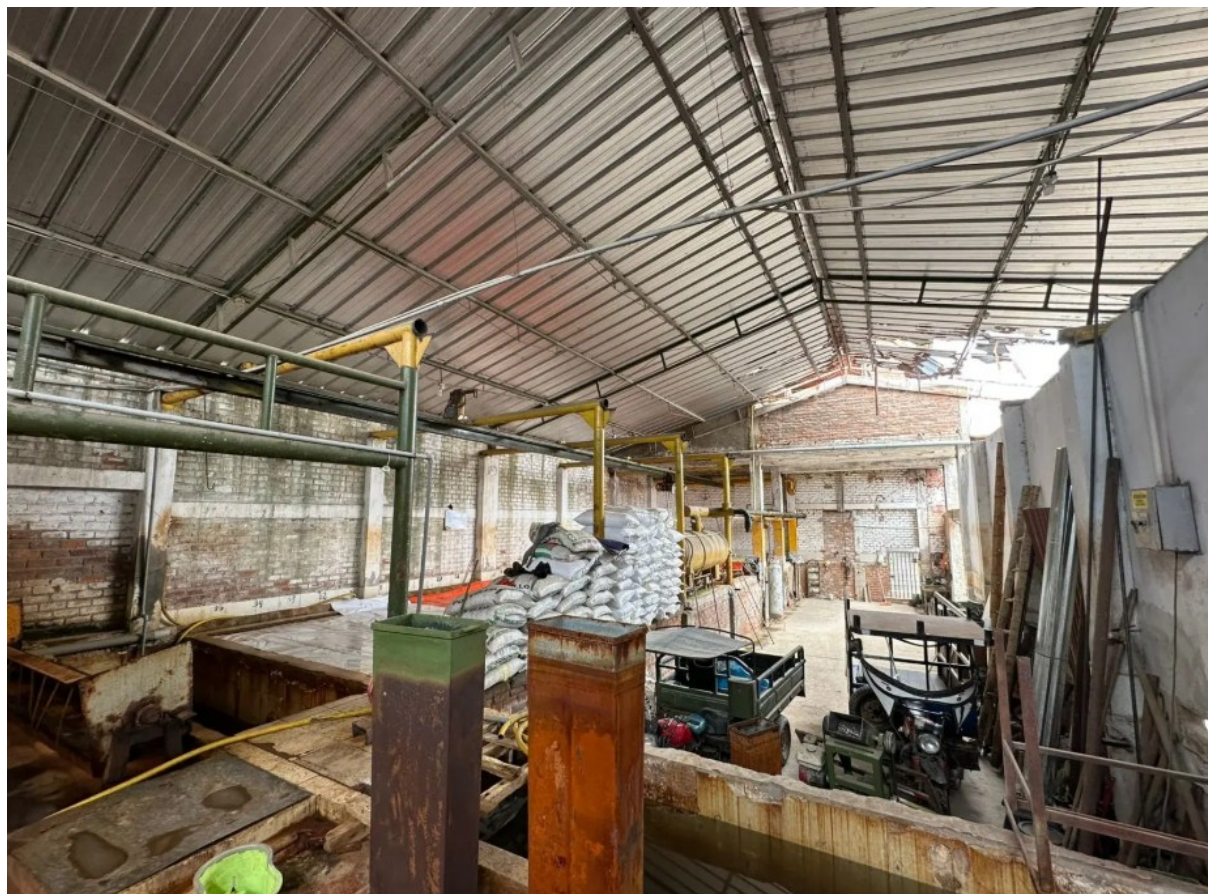
Figura 48 Imagen de uno de los ambientes del local industrial
