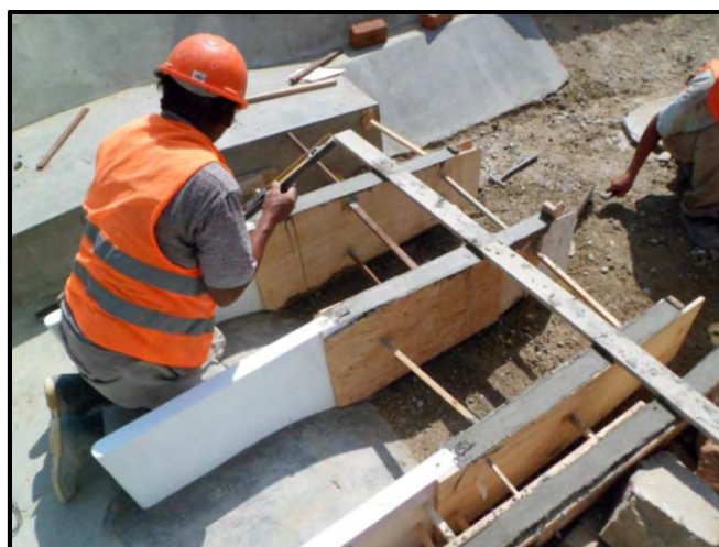
Figura 4.11. Construcción de estructuras.
