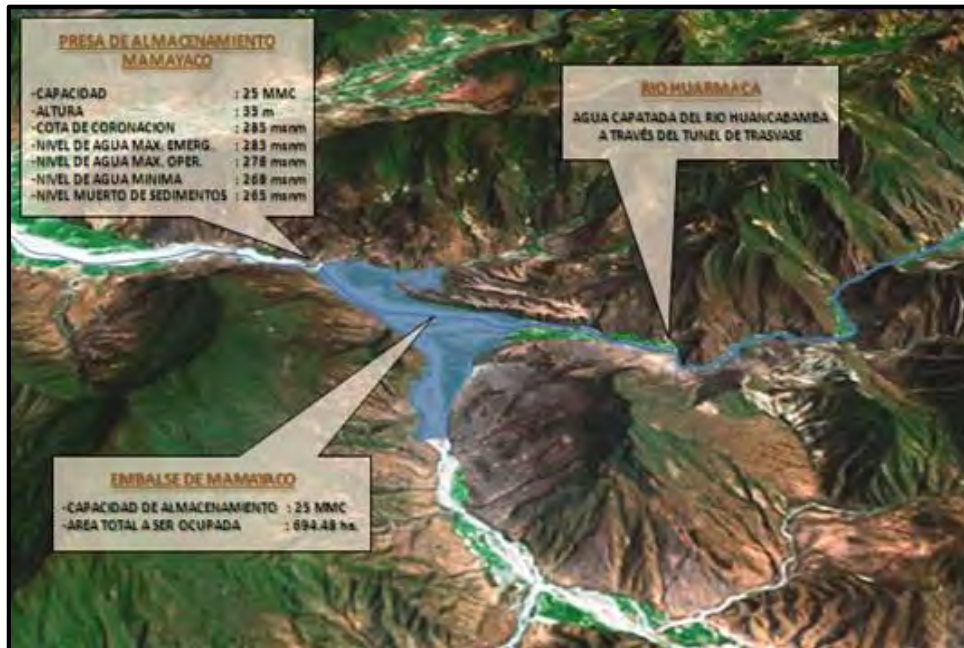
Figura 1.13. Ubicación de presa Mamayaco.
