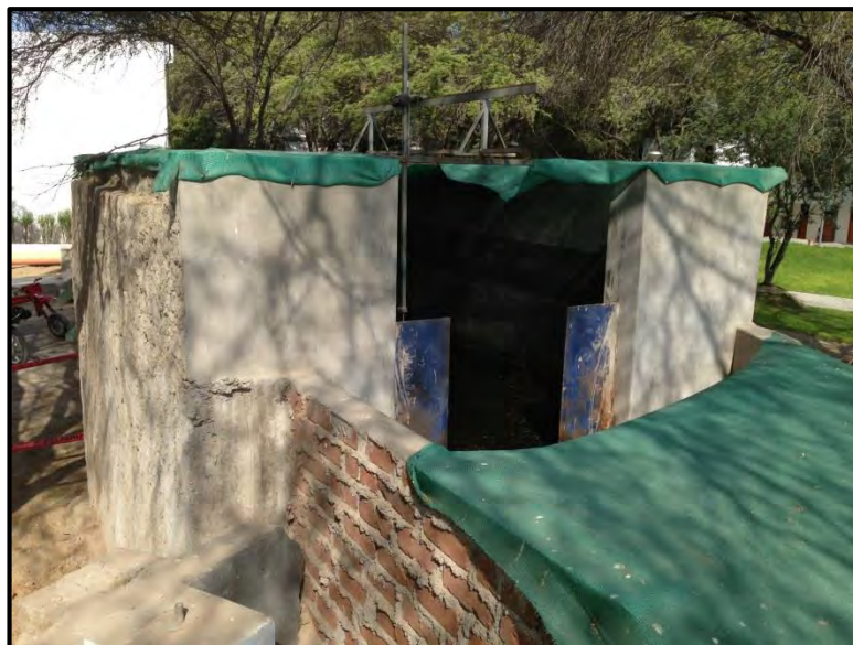
Figura 4.6. Tanque de quietamiento y vertedero.
