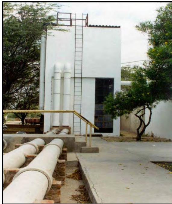
Figura 4.3. Cuarto de Bombas.
