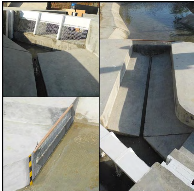
Figura 4.13. Construcción de canal de aproximación.
