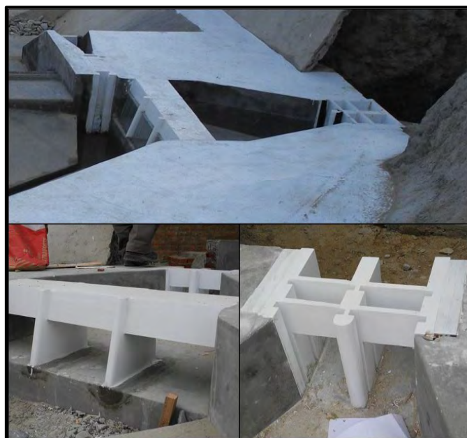
Figura 4.14. Construcción de la bocatoma.
