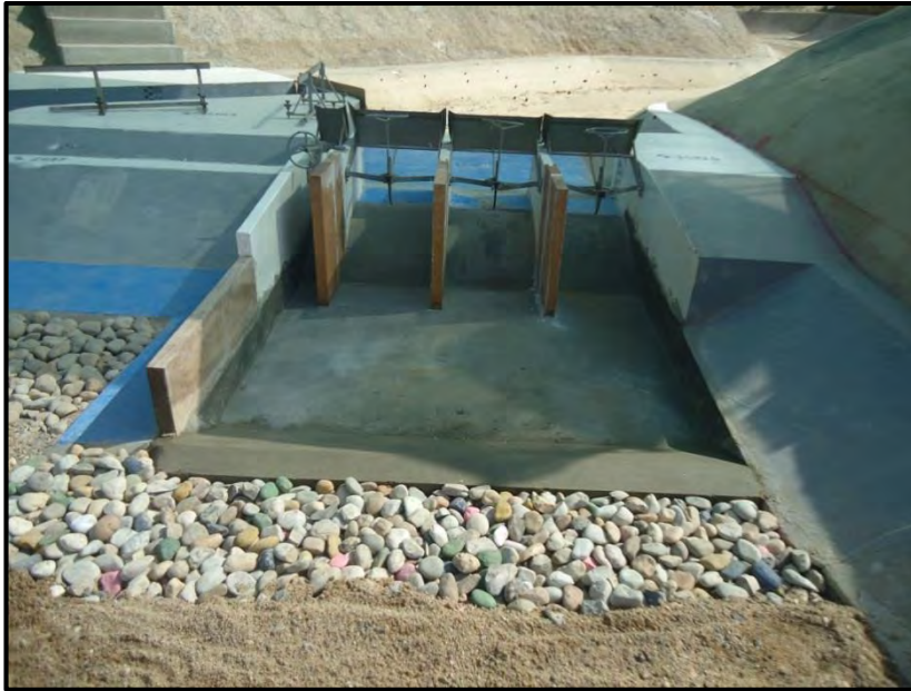
Figura 5.13. Poza disipadora construida.
