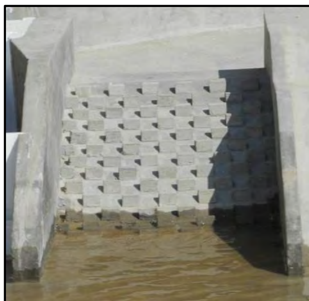
Figura 4.15. Vertedero de demasías.
