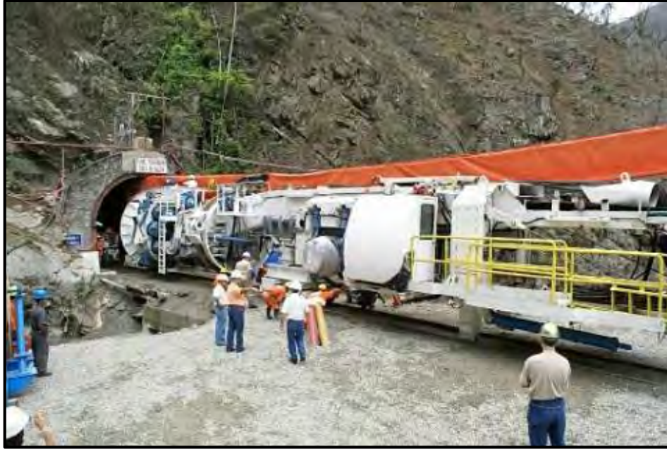
Figura 1.12. Construcción de túnel de trasvase.
