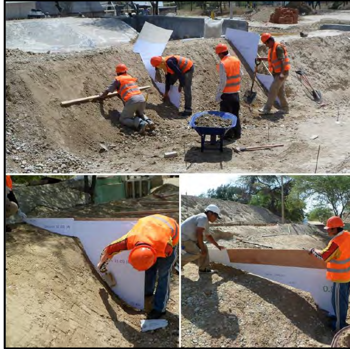
Figura 4.9. Construcción del cauce del modelo.
