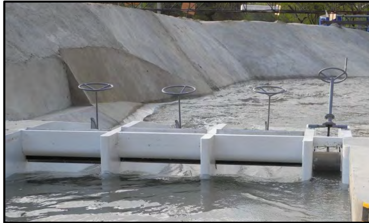
Figura 4.12. Vista de barraje móvil construido.
