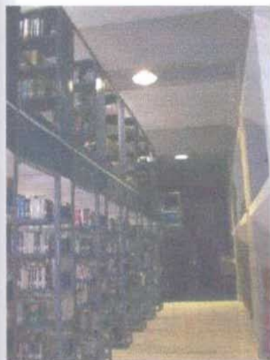
a) Iluminación de pasillo 1er nivel
