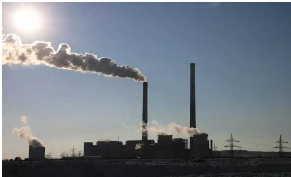
Figura 2. Emisión de gases en central térmica. La contaminación ambiental riesgo para la salud de los seres vivos que habitan los ecosistemas contaminados, incluyendo a los seres humanos
