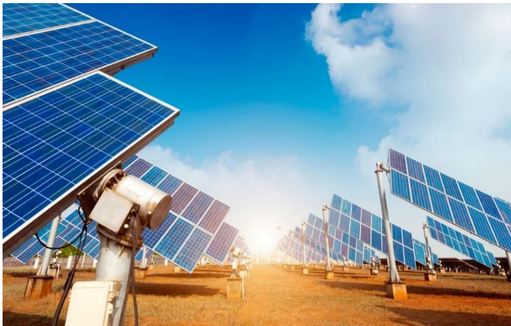
Figura 14. Instalación de paneles solares 8
