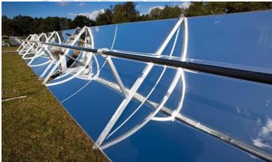
Figura 29. Transformador de energía solar térmica en energía eléctrica
