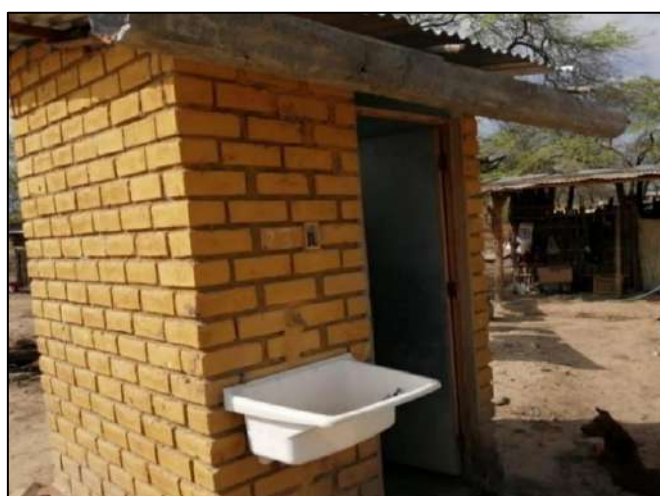
Figura 12. Vivienda con unidad básica de saneamiento existente
