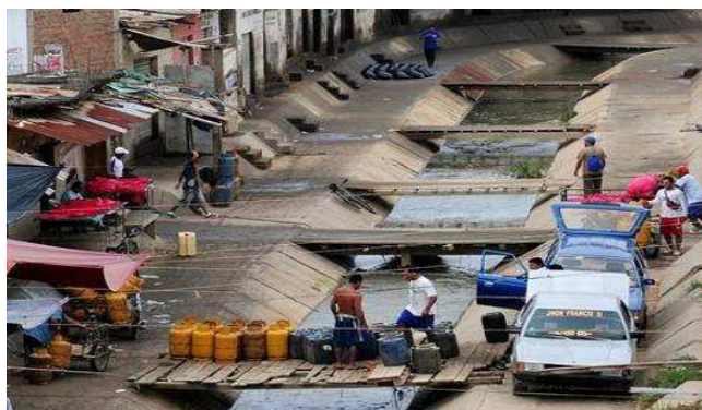
Figura 5.3. Puentes de madera que une Huaquillas con Aguas Verdes
