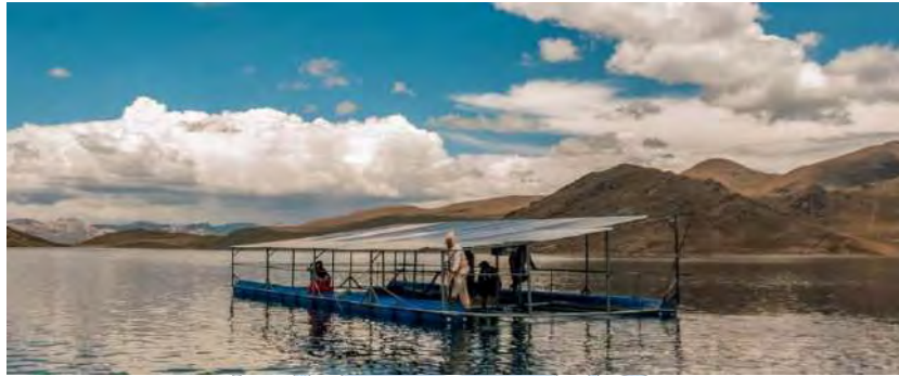
Figura 2. Paneles solares flotantes en la Comunidad Chullpia, Puno
