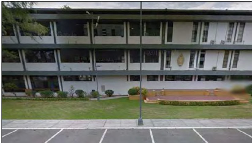
Figura 16. Playa de estacionamiento N.º 02 de la Universidad de Piura
