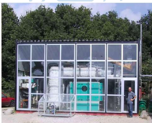
Figura 20. Planta de gasificación.
