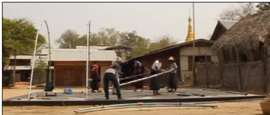
Figura 37: Armado de la estructura del secador
