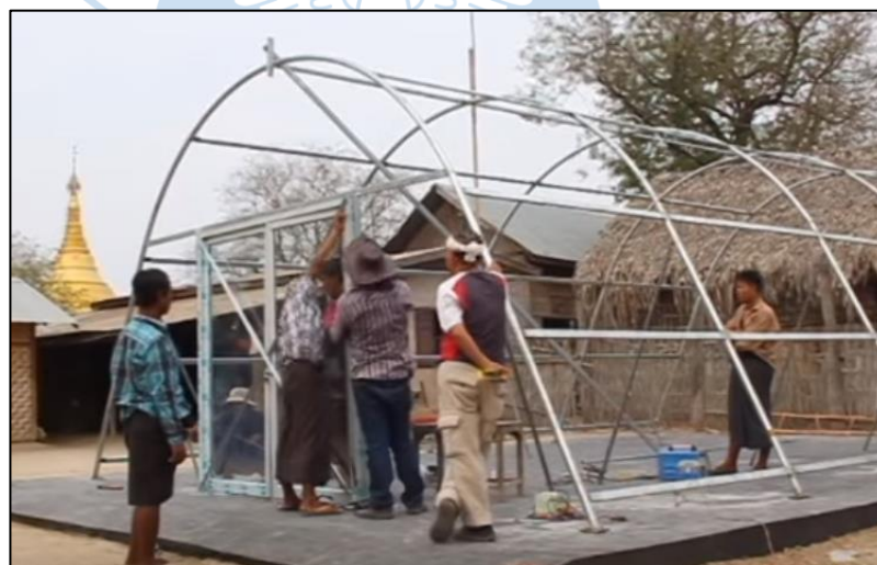
Figura 38: Instalación de la puerta del secador
