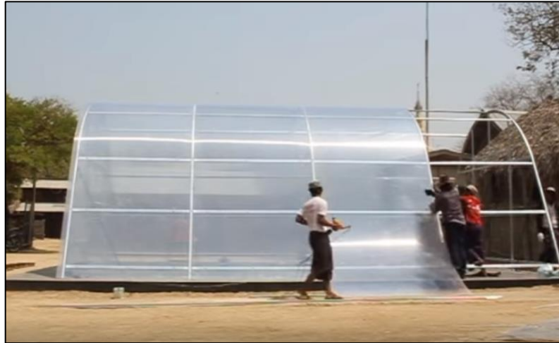
Figura 39: Instalación de la cubierta transparente del secador
