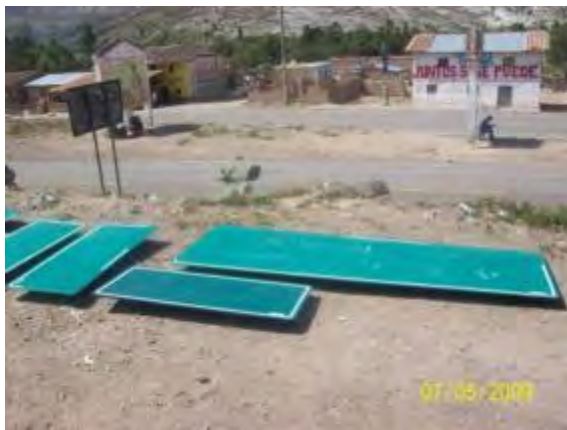
Foto 2.18 Reparación de señal informativa
