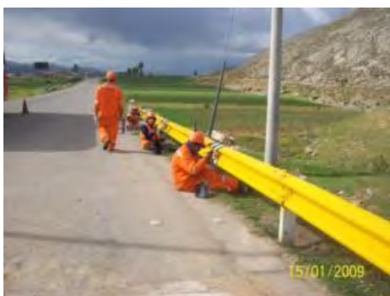
Foto 2.22 Mantenimiento de Guardavías
