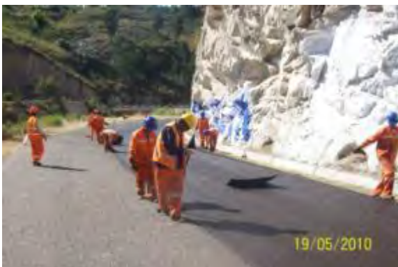
Foto 3.41 Acabado de lechada asfáltica
