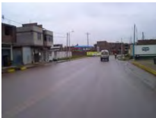
Foto 1.1 Inicio del tramo Asfaltado (Salida de Huancayo)
