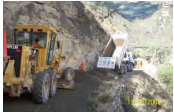
Foto 3.9 Tendido con motoniveladora
