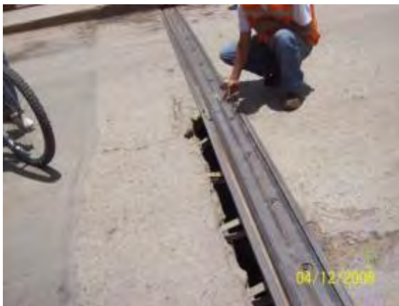
Foto 2.8 Reparación de Junta
