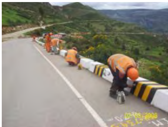
Foto 2.26 Pintado de Muros
