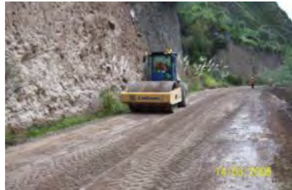
Foto 2.41 Compactación de vía
