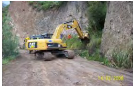
Foto 2.31 Limpieza de quebrada
