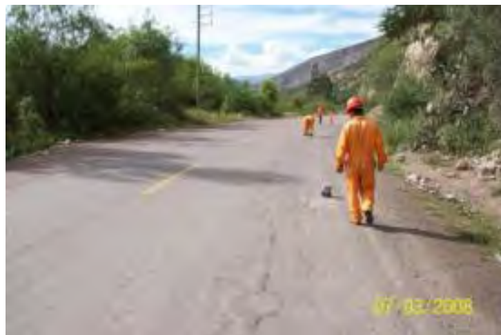
Foto 1.4 Se aprecia las fisuras longitudinales en la vía asfaltada
