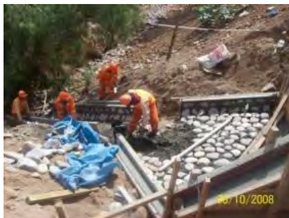
Foto 3.23 Emboquillado descarga
