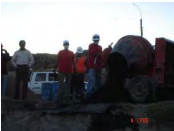
Foto 2.12 Mezcla con Emulsión
