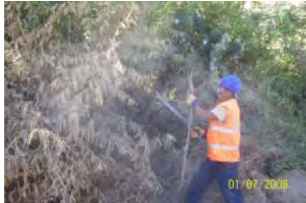
Foto 2.29 Trabajos de Roce Manual
