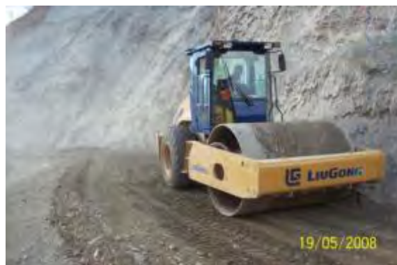
Foto 3.12 Compactación de material
