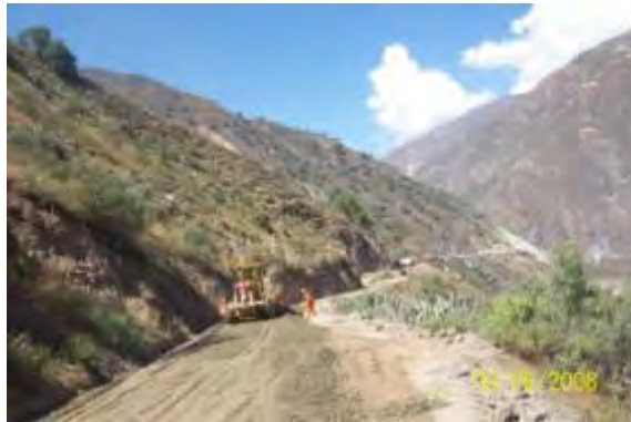
Foto 3.10 Conformación con motoniveladora
