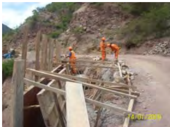
Foto 3.21 Encofrado de muros
