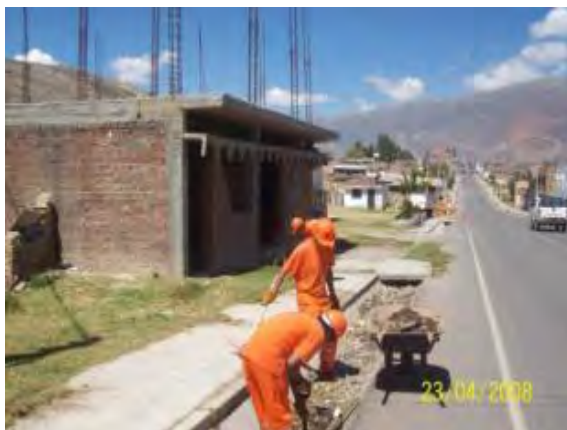
Foto 2.3 Cuneta revestida colmatada
