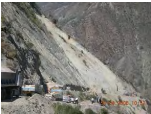
Foto 3.1 Remoción de derrumbe
