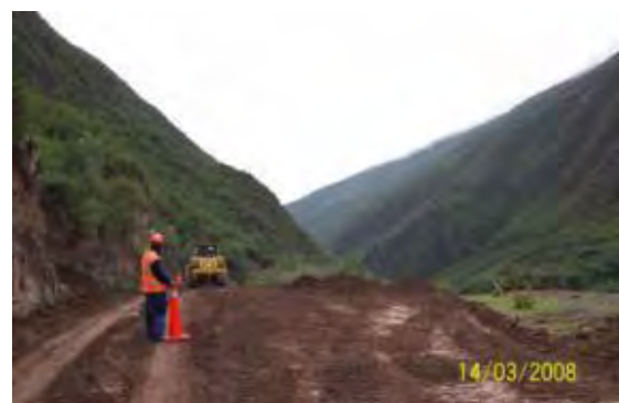
Foto 2.37 Tendido de material con Tractor
