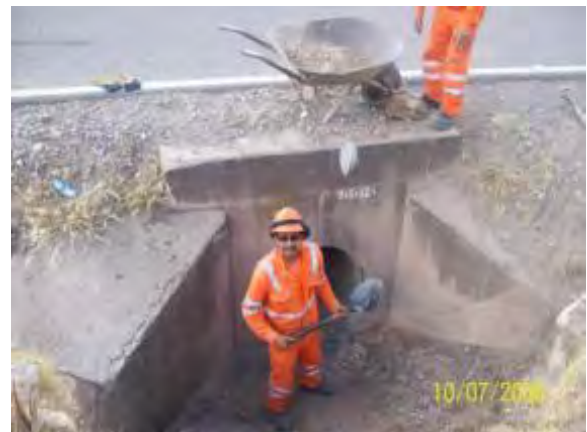
Foto 2.7 Limpieza manual de alcantarilla
