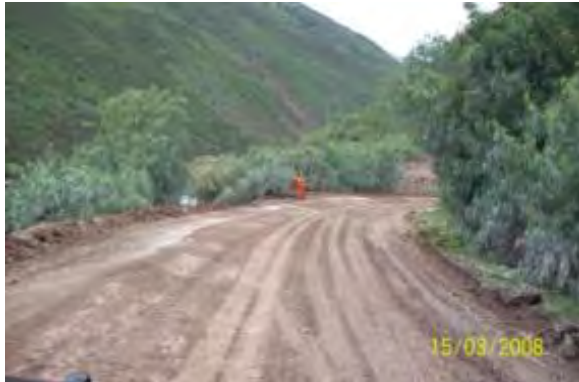
Foto 2.40 Plataforma lista para compactar
