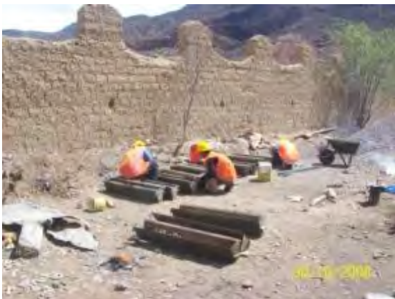
Foto 3.32 encofrado de hitos kilométricos
