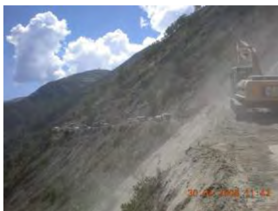
Foto 3.2 Excavadora en pleno trabajo
