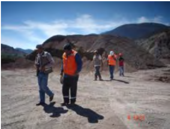
Foto 2.10 Preparación de agregados
