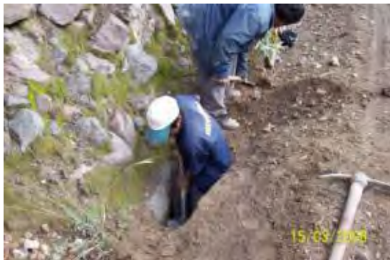
Foto 2.30 Limpieza manual de Alcantarillas
