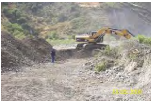
Foto 3.3 Explotación de cantera
