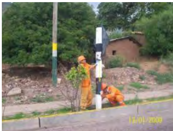
Foto 2.20 Mantenimiento de señal vertical
