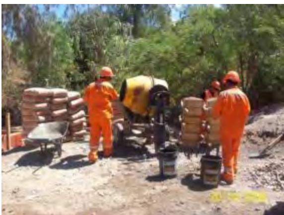
Foto 3.18 Preparación de concreto
