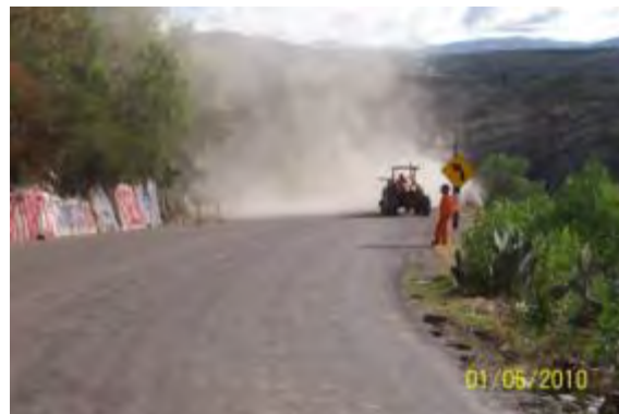
Foto 3.38 Limpieza previa a la colocación de la lechada asfáltica
