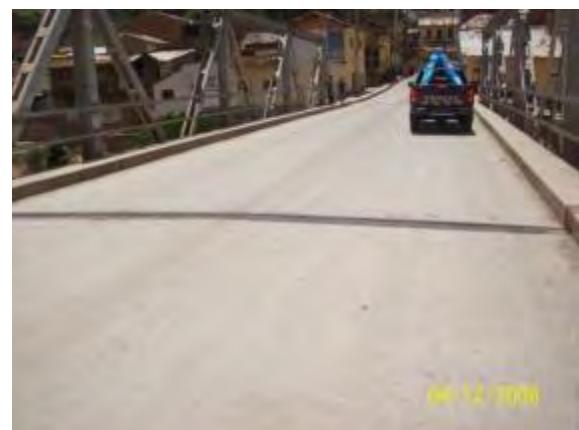
Foto 2.9 Junta de Puente reparada
