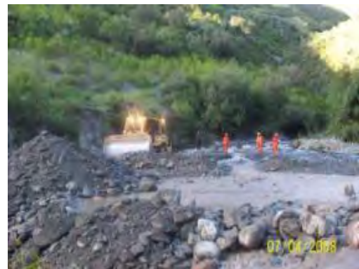
Foto 2.49 Tractor acondicionando cauce
