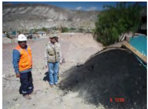
Foto 2.13 Acopio de mezcla en frio
