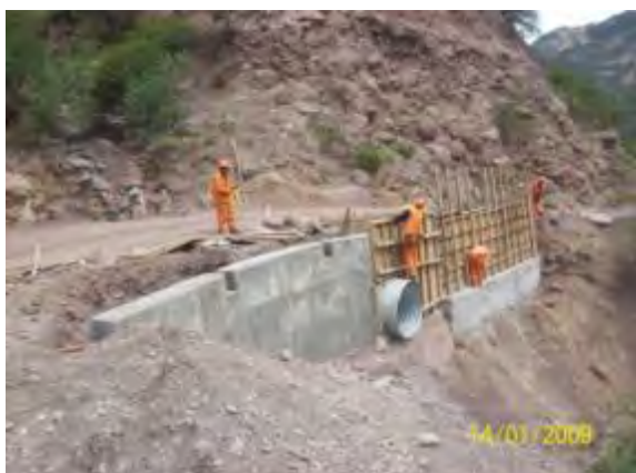
Foto 3.20 Muros en la Alcantarilla
