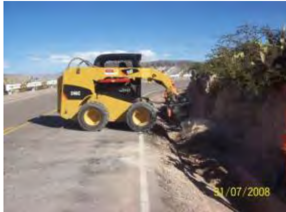
Foto 2.5 Limpieza de cuneta con equipo
