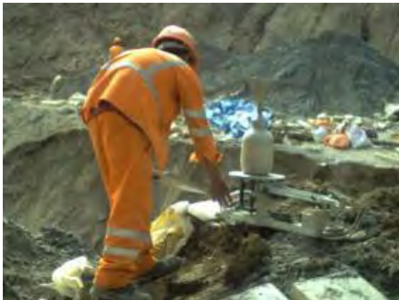
Foto 3.26 Controles de compactación
