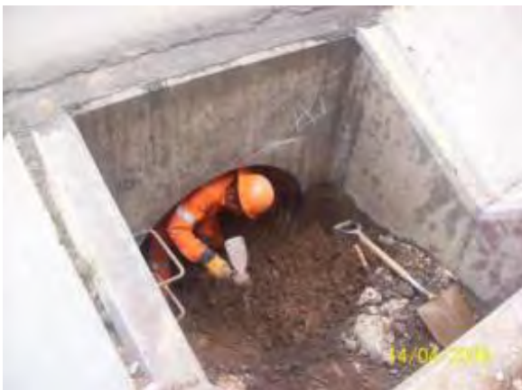
Foto 2.6 Alcantarilla colmatada
