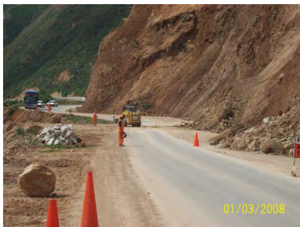
Foto 2.28 Limpieza de derrumbes con equipo
