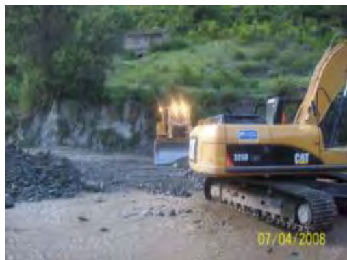
Foto 2.48 Trabajo en conjunto en cauce
