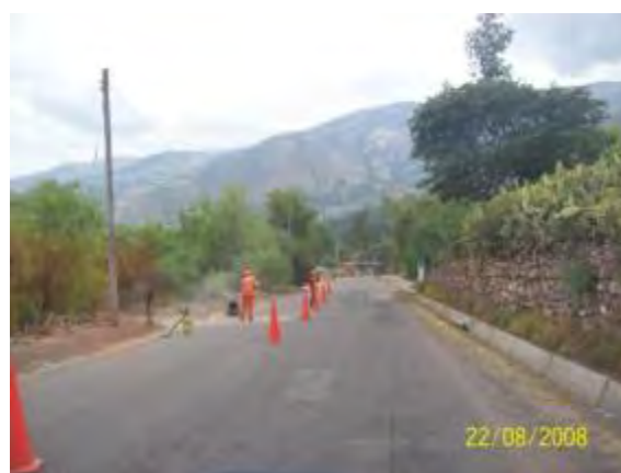
Foto 2.17 Limpieza de Parche
