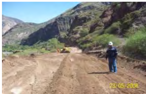
Foto 3.11 Supervisando los trabajos
