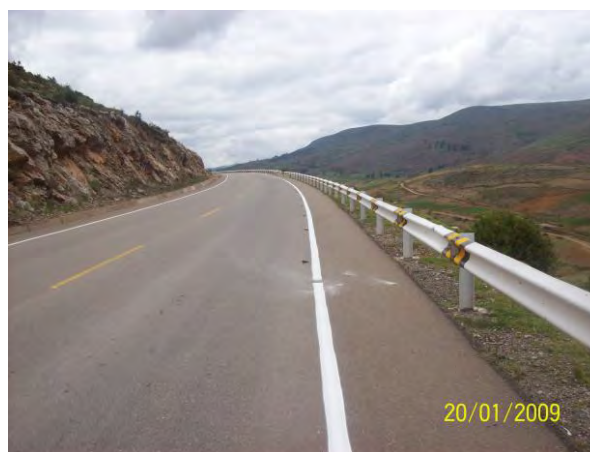
Foto 2.27 Marcas en pavimento
