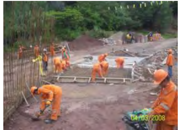
Foto 3.27 Solado previo a la losa
