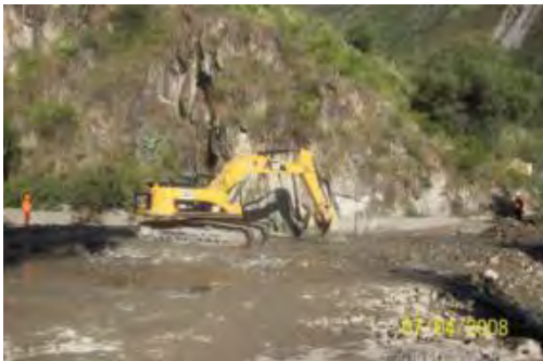
Foto 2.46 Limpieza de Cauce
