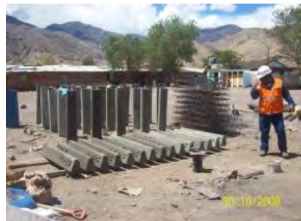
Foto 3.33 Hitos kilométricos terminados
