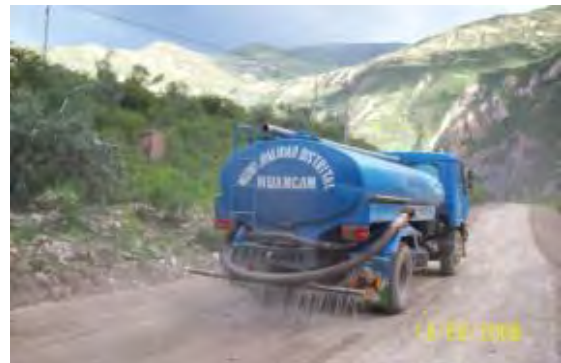
Foto 2.35 Riego de plataforma
