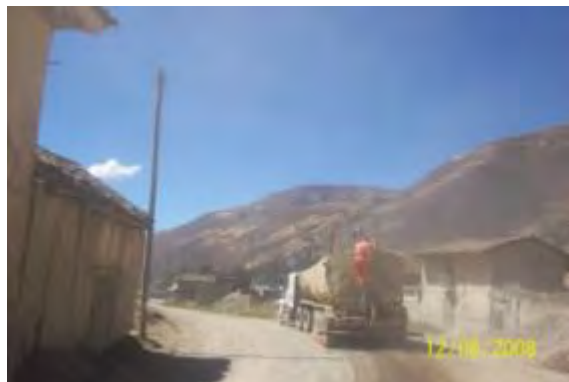
Foto 3.13 Riego de plataforma
