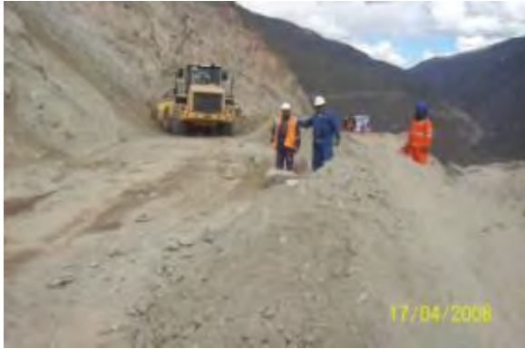
Foto 2.52 Limpieza de derrumbe con cargador
