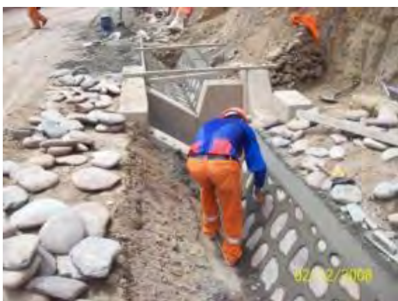
Foto 3.22 Emboquillado a la entrada
