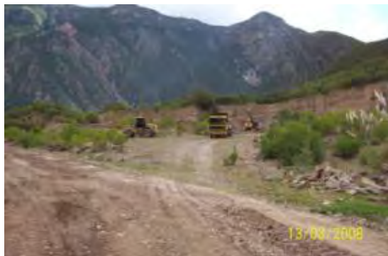
Foto 2.34 Extracción de material de Cantera
