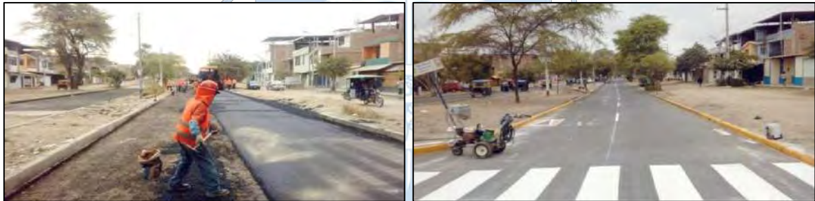
Figura 36. Rehabilitación de la Av. Don Bosco en el 2017 por medio de la Municipalidad Provincial de Piura. Tramo Av. Gullman- Av. Bolognesi.
