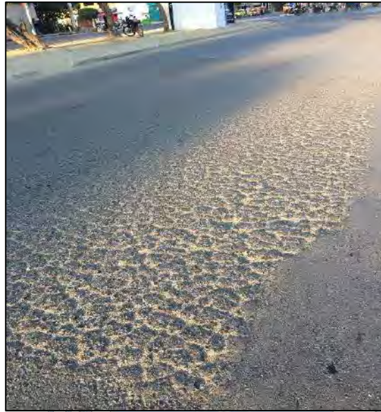
Figura D1. Piel de cocodrilo de severidad alta encontrada en la unidad UM28.
