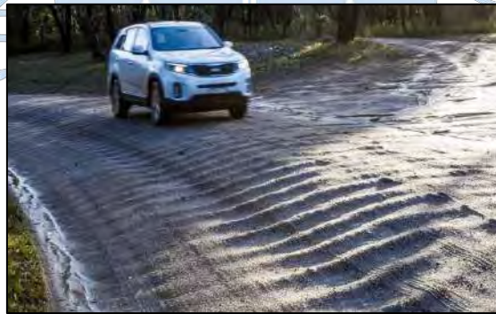
Figura 17. Corrugación en pavimento flexible.
