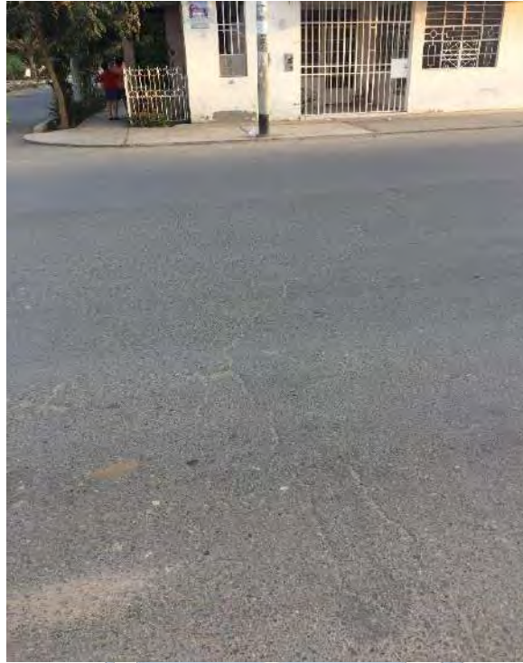
Figura D5. Fisura transversal de severidad media en la unidad UM35.
