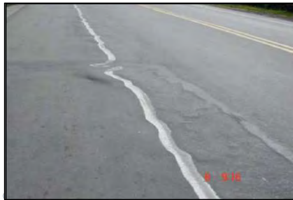
Figura 20. Desplazamiento en pavimento flexible.
