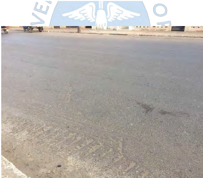
Figura D4. Peladura y fisura transversal de severidad media en la unidad UM33.
