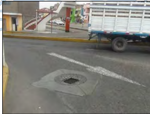
Figura 28. Parche de corte utilitario en pavimentos flexibles.
